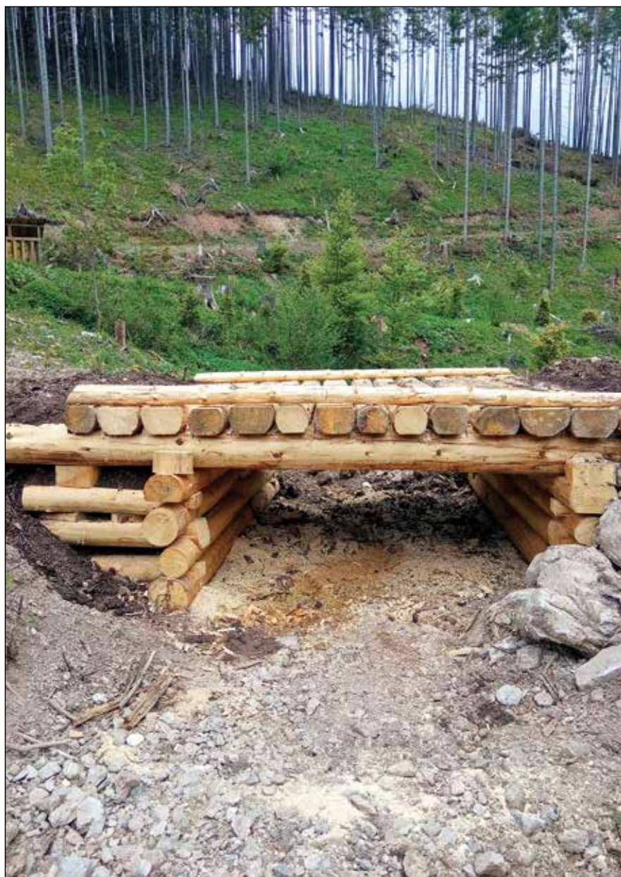
OPRAVENÝ MOST V DOLINE ČIERNY POTOK (2017)
