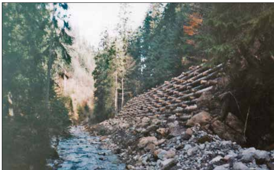
VÝSTAVBA OPORNÉHO MÚRU TZV. IZBICE, LOKALITA LESNÁ CESTA SOLNISKO (1998)
